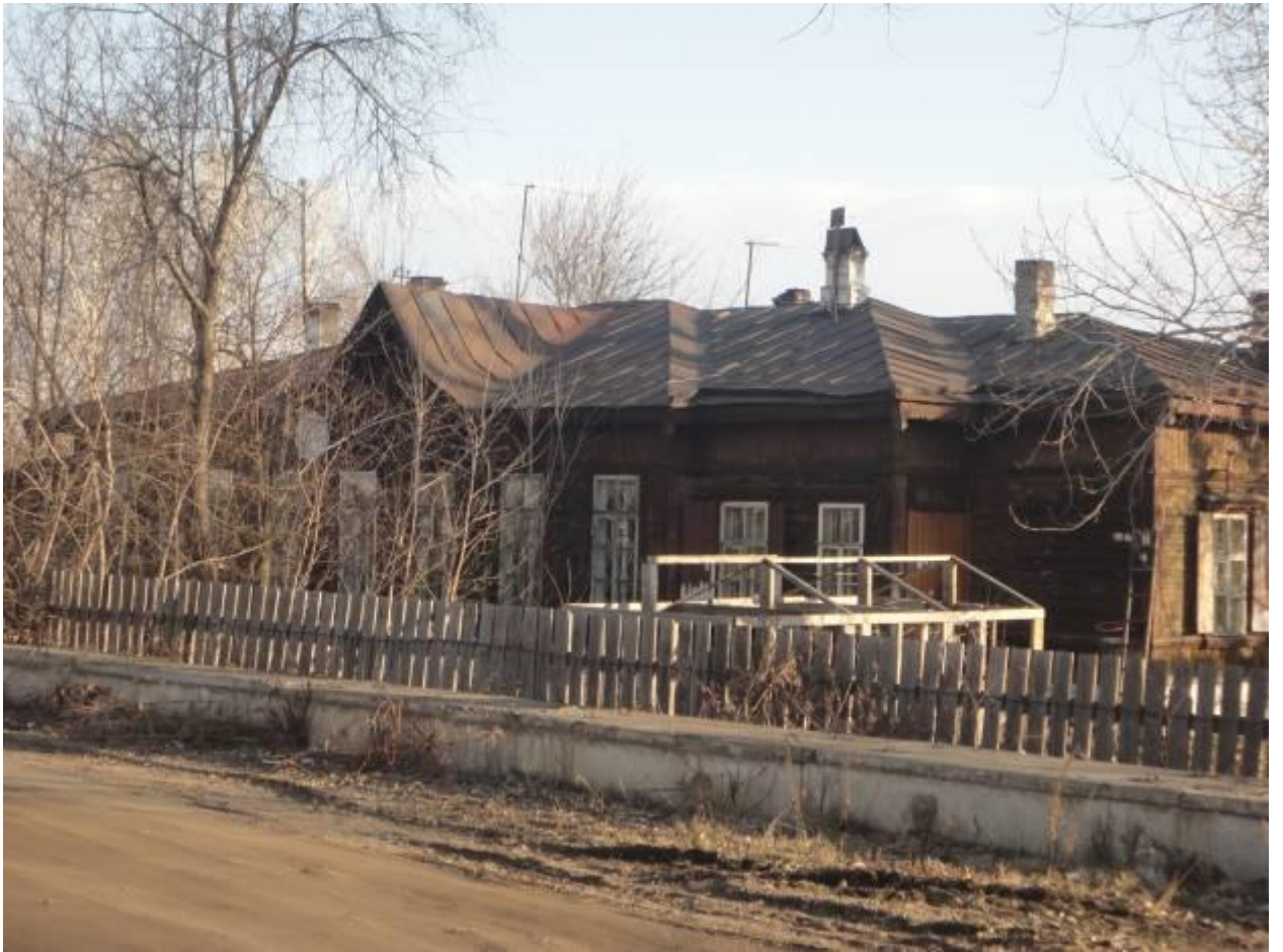
Здания первой улицы поселка рабочих и служащих станции Тайшет - Северовокзальной. Фото 2013 г.
