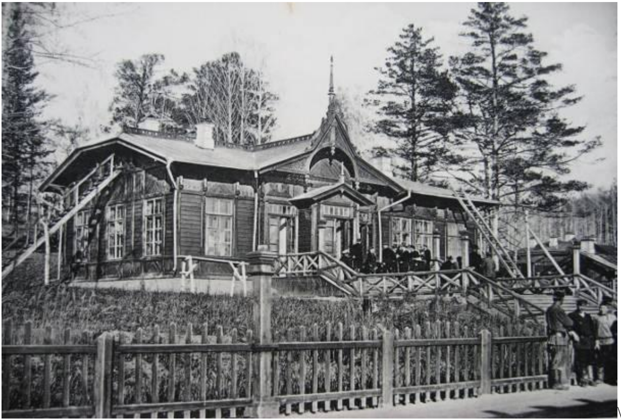
Пассажирское здание ст.Ключи. 1910 г. 109
