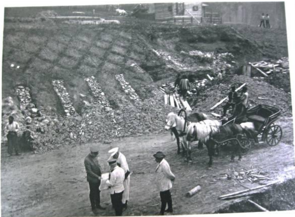
2391 ВЕРСТА. ВИД УКРЕПЛЕНИЯ ОТКОСОВ ГРЯЗНОЙ ВЫЕМКИ БЛИЗЬ СТ. КЛЮЧИ.
