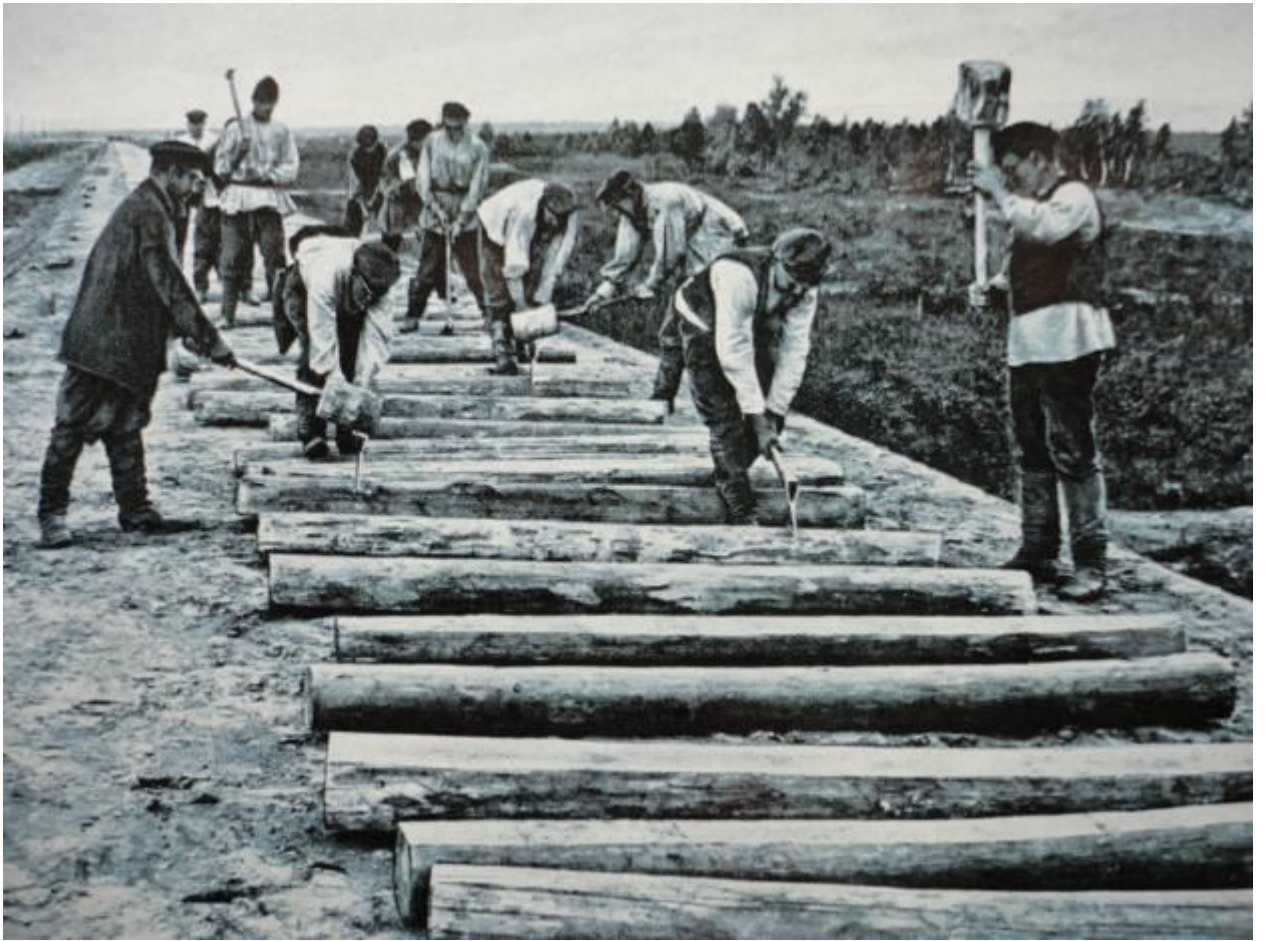
Укладка железнодорожного пути вручную
