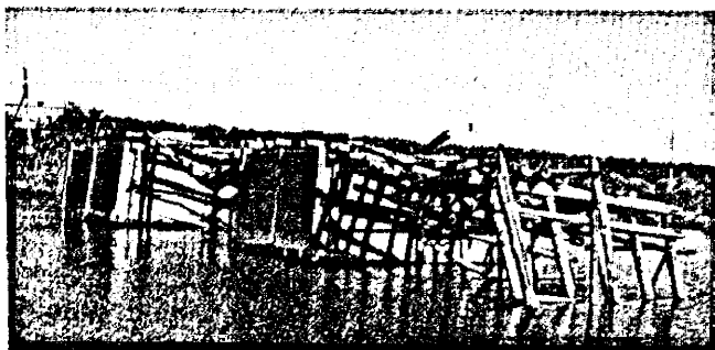
Остатки деревянного моста через реку Кама, в селе Туруновка. Постройки 60-х годов XIX вв. в с. Венгерово
